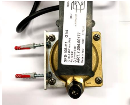
Fig.4-5 – IT- Avvitare la staffa (D) al differenziale di pressione (F) nel lato specularmente opposto a quello con il segno “-“ (cerchiato). EN- Screw the metal bracket (D) to the differential of pressure (F) in the symmetrically opposite side of the one with the “-“ sign (circled). FR- Visser le support (D) sur le différentiel de pression (F) du côté opposé à celui portant le signe “-“ (entouré). ES- Enroscar el soporte metálico (D) en el presostato diferencial (F), en el lado simétricamente opuesto a aquel con el marcador “-“ (señalado en la imagen).
